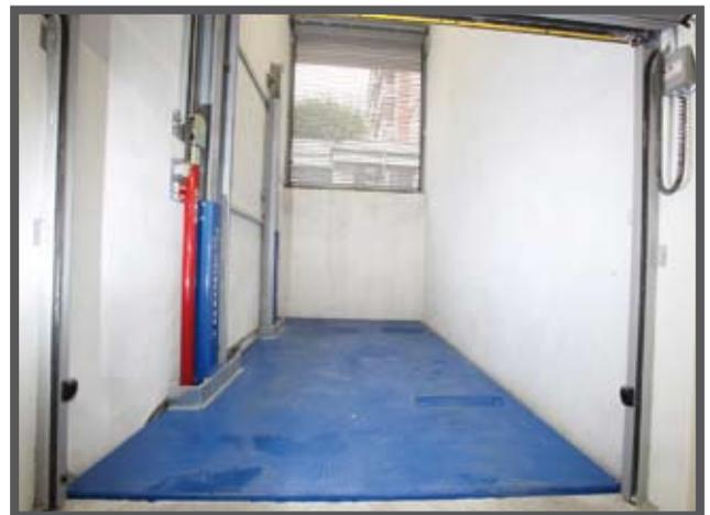
Vues d'ensemble de la machine (à titre d'information, les photos ont été prises lors d'une opération de maintenance. Pendant ce processus, il est impossible d'ouvrir les portes si la plateforme ne se situe pas au même niveau).
