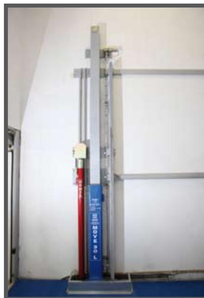
Lorsque la plateforme a transité jusqu'à la hauteur maximale, le groupe du piston, le patin de guidage et le taquet de blocage dépassent le niveau
