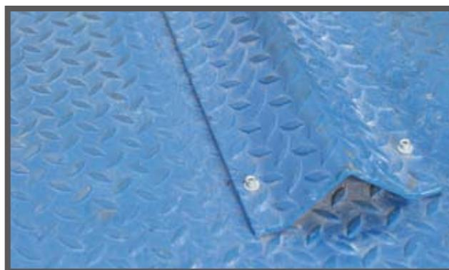
Photo détaillée de la cale roue avant, conçue pour garantir le bon positionnement du véhicule et pour éviter les éventuels cahots lors du transit de la plateforme. Cet élément se trouve également sur la partie arrière.
